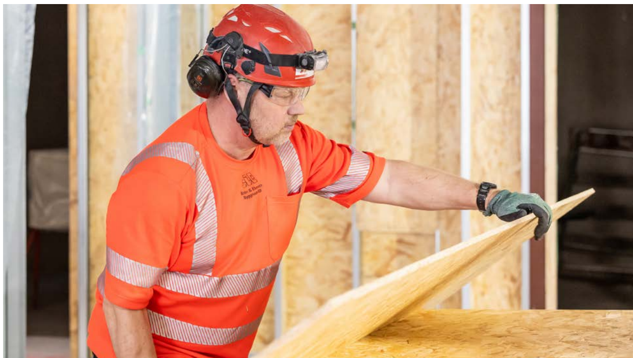
Arbete under byggandet av Hus C på garnisonsområdet i Linköping. Åhlin & Ekeröth genomför projektet som en samverkansentreprenad tillsammans med Intea Garnisonen AB och Region Östergötland.
